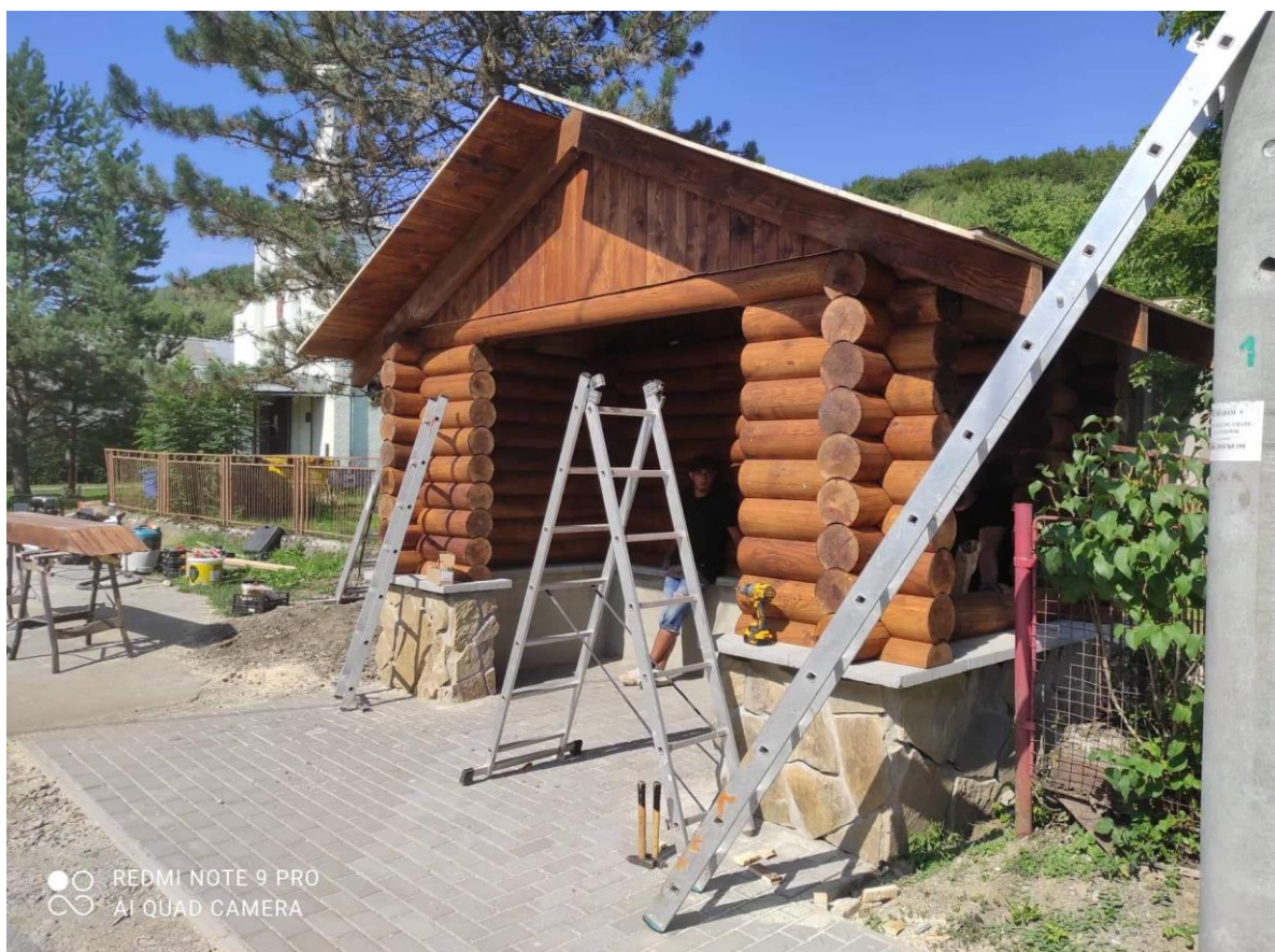
Výstavba zastávky č. 1 v obci Pstriná
