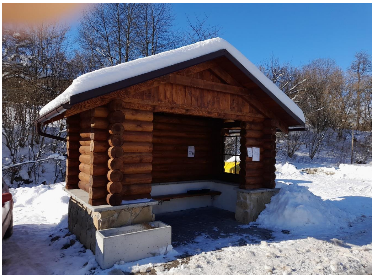
Autobusová zastávka č. 2 v obci Pstriná po realizácií
