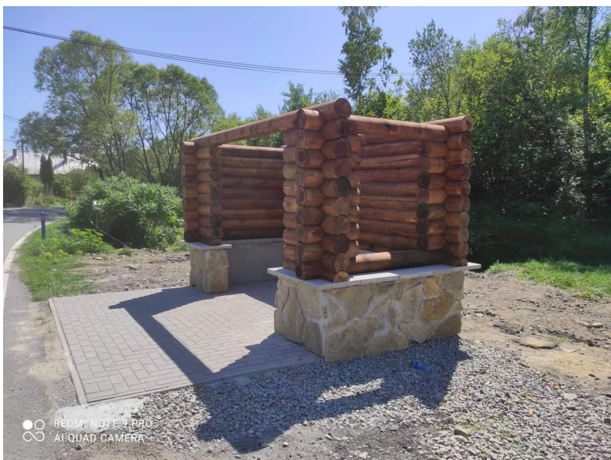
Výstavba zastávky č. 2 v obci Pstriná
