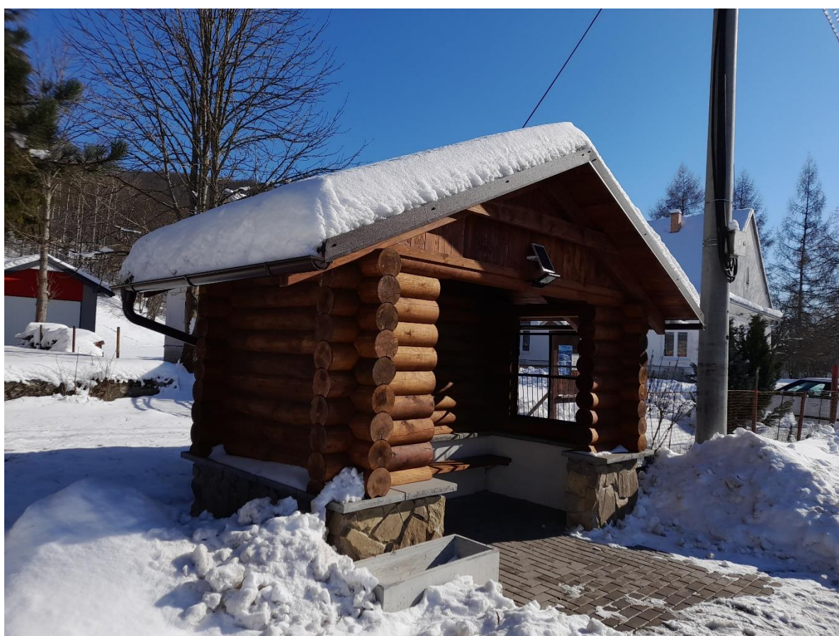
Autobusová zastávka č. 1 v obci Pstriná po realizácií
